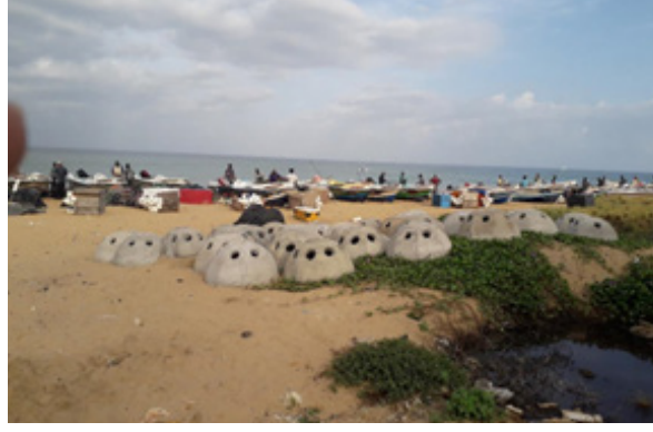
பவளப்பாறைகளுக்கு பதிலாக கான்கிரீட் அடி மூலக்கூறுகள் பயன்படுத்தப்படுகின்றன
