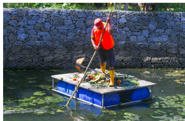
ආබෘ ඇළ හරහා ස්ථාපිත කළ කසල රඳවනය සහ ඒ මත රැඳෙන අපද්‍රව්‍ය ඉවත්කිරීම සිදු කරන අවස්ථාව
